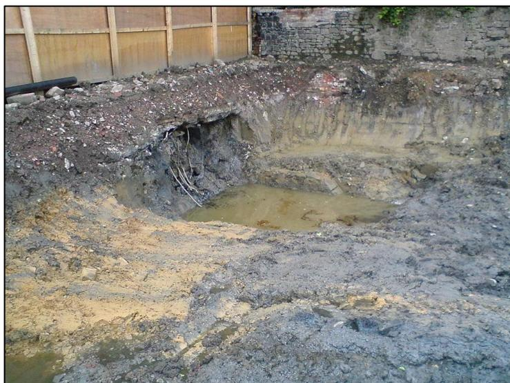
Imagen 18: Contaminación del suelo por depósitos subterráneos de almacenamiento de alquitrán.
